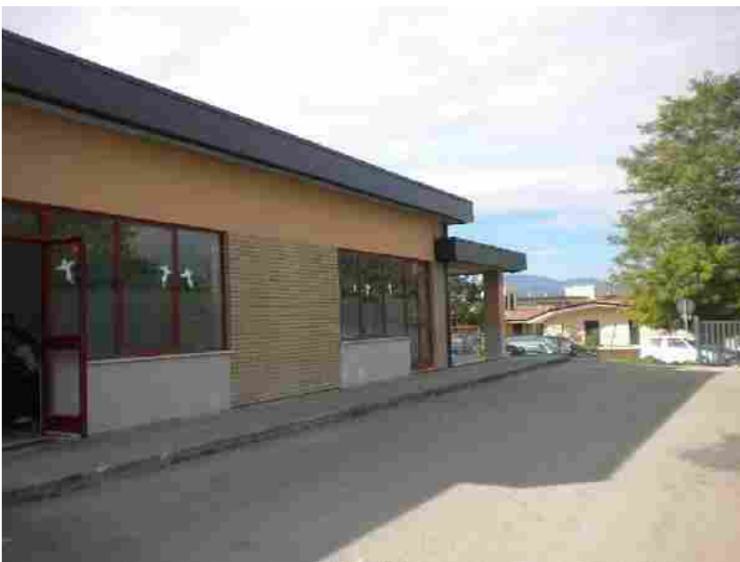
Il primo istituto comprensivo
